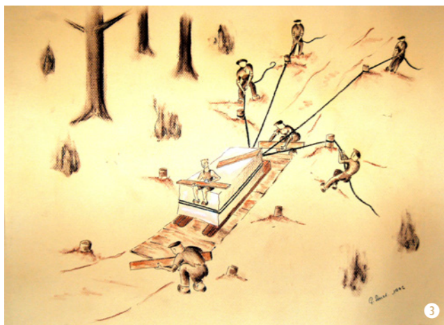
Illustrations de G. Serres (1996): ① Blocs en carrière prêts pour l'expédition. ② Transport sur terrain plat et en côte nécessitant un nombre variable de bœufs. ③ Transport dans les descentes sur des chemins aménagés dits chemins de lisses. ④ Transport sur rivière.
